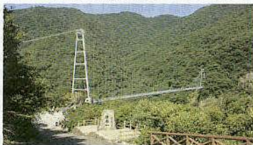
照葉樹大吊橋
